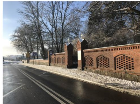
Miejsce po budowlu w 2017 r.
